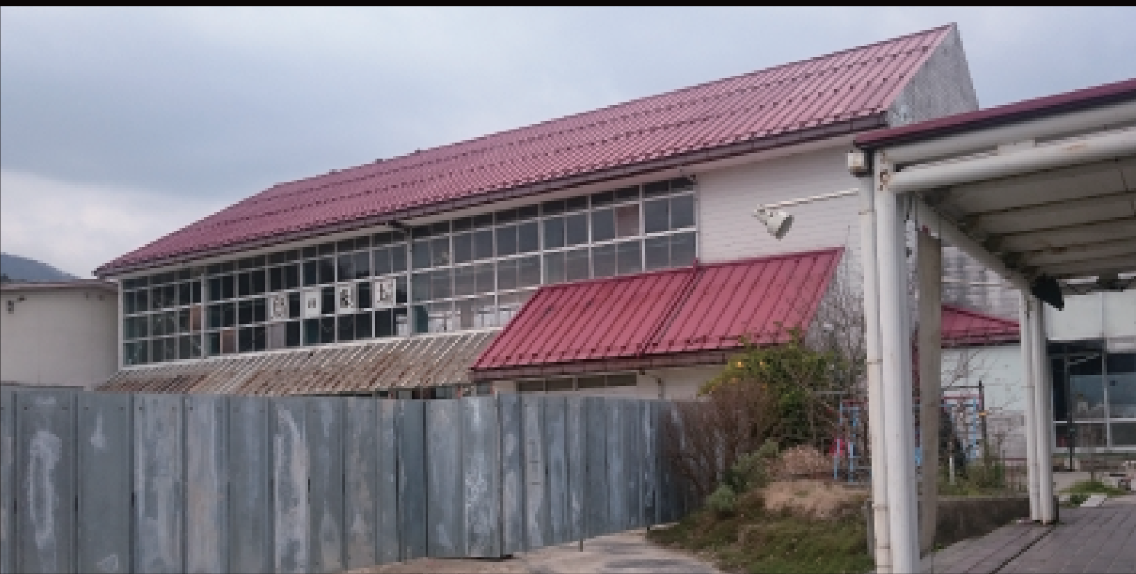
改修工事直前の体育館。
