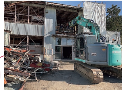
2023年12月 旧校舎解体
