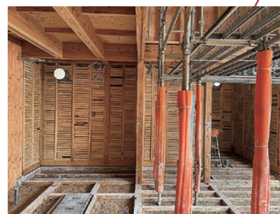
2024年12月 もみから断熱材の施工
